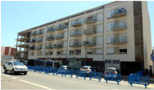
Desallotjament d'un edifici ocupat a Sant Antoni de Calonge
