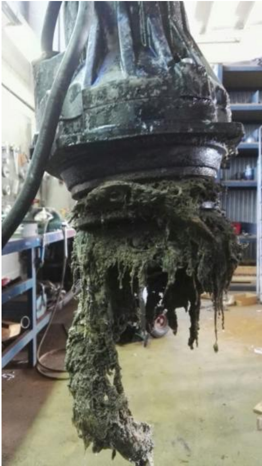
Aspecte de com ha quedat una bomba de l'estació de bombeig
