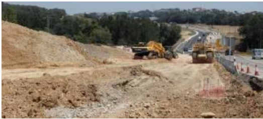
El tram en obres del desdoblament de l'N-II al seu pas pel terme municipal de Vilademuls.
