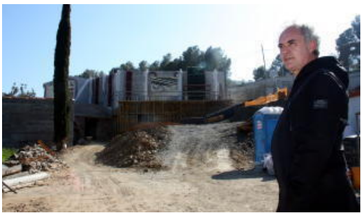
Obres d'ampliació del nou Bulli
