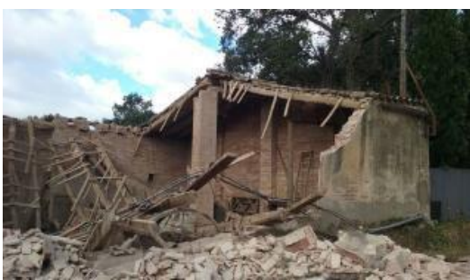
Caiguda del mur d'una nau a Calonge
