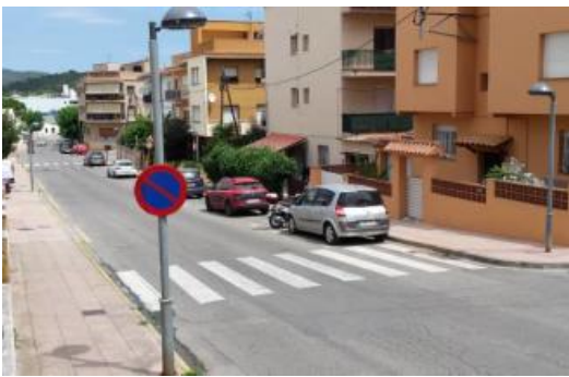
Sant Joan Renovació d'enllumenat públic
