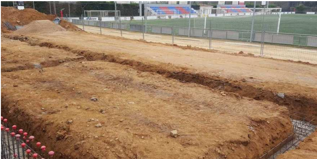
Obres 1a fase bar camp de futbol
