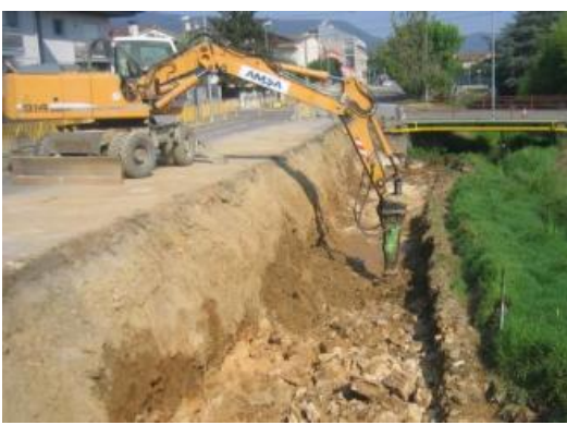
Una màquina realitzant obres al carril bici de Porqueres.
