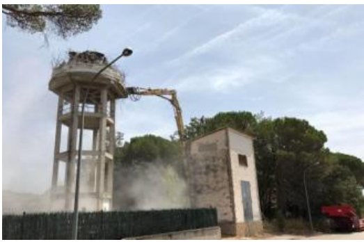
Enderroquen el dipòsit de Mas Flassià
