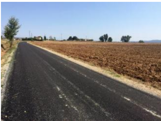
El tram asfaltat, amb Mas Usall de fons.
