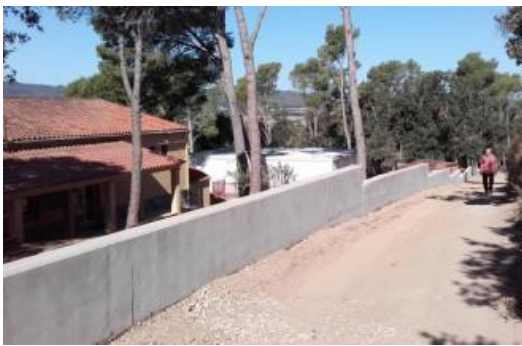
A l'escola d'Esclanyà s'hi ha fet un mur de contenció.
