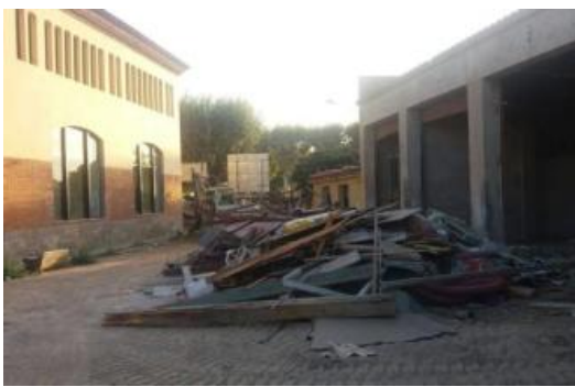
L'actuació comporta l'enderroc de l'antic parc de bombers.
