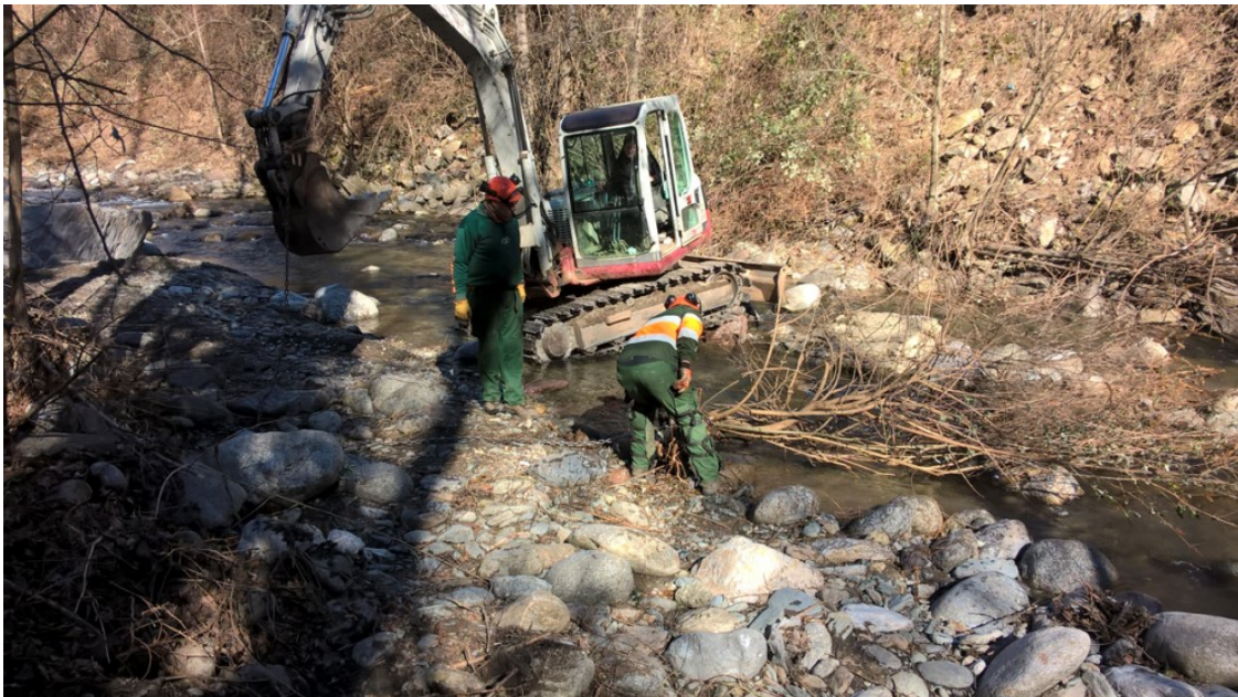
Zona del pont de la Cabreta després de l'actuació | Diputació de Girona
