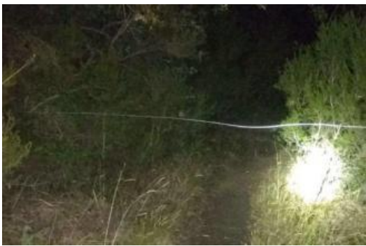
Un dels cablejats detectats a l'Ardenya aquesta setmana.
