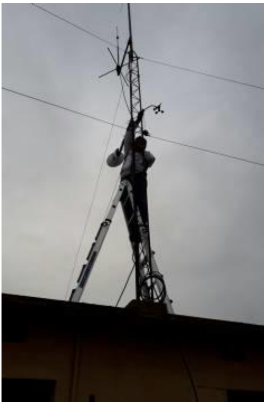
Instal·lació de l'aparell.
