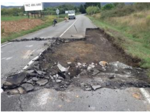
Treballs d'asfaltat a la ronda de Roses.
