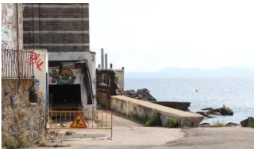
Enderroc antiga depuradora de marisc de Roses
