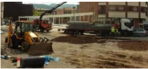
Treuen l'estructura provisional de la plaça Mercat d'Olot
