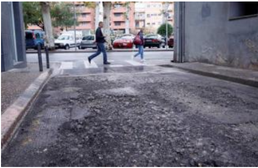
Treballs d'asfaltatge a Girona interromputs per la pluja
