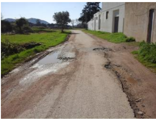
Roses asfaltarà properament 36 carrers
