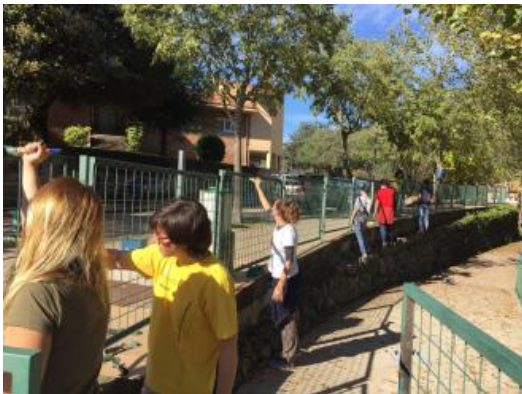
Membres de l'AMPA, col·laborant en les obres de la tanca
