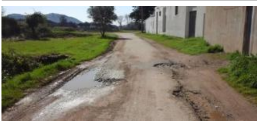
Un dels carrers pendents d'asfaltar.
