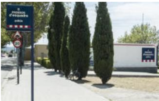
L'Oficina d'Atenció Ciutadana, en el mòdul prefabricat on està ubicada.
