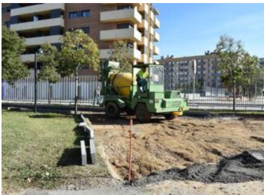
Maquinària treballant al parc hospitalari Martí i Julià.
