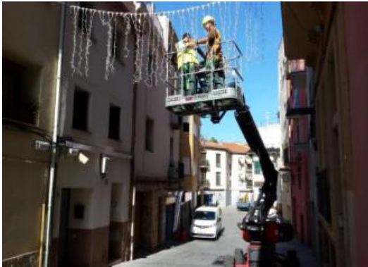
Operaris de la Brigada municipal realitzant el muntatge.
