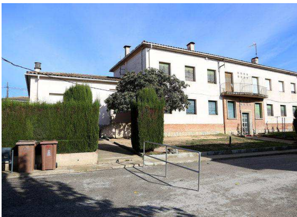
Una imatge d'uns contenidors a l'edifici de l'antiga casa dels mestres de Caldes. Foto: QUIM PUIG.
