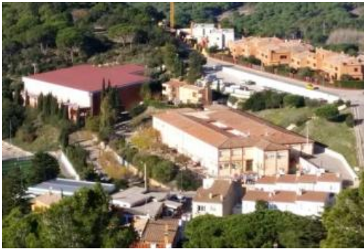
Begur posarà una caldera de biomassa per a l'escola Doctor Arruga i el pavelló
