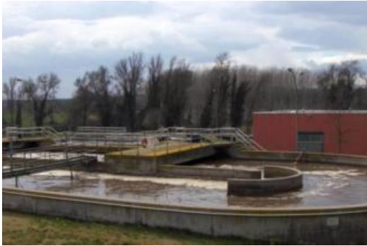
L'estat actual de la depuradora.
