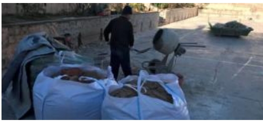
Imatge dels treballs que es fan a la pista poliesportiva.
