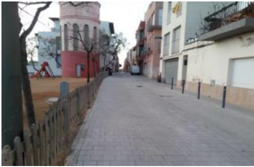
Palamós Acaben les obres d'arranjament del carrer Pedró
