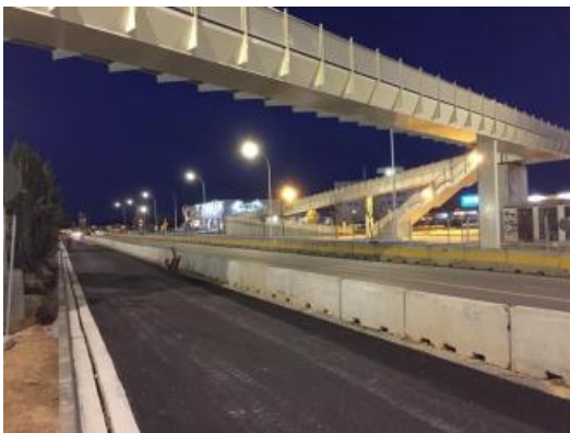
Les obres estan a punt d'acabar.
