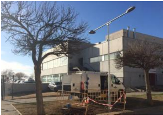
Ja s'han instal·lat alguns dels nous fanals.
