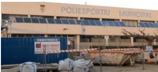
L'exterior de l'equipament en obres.
