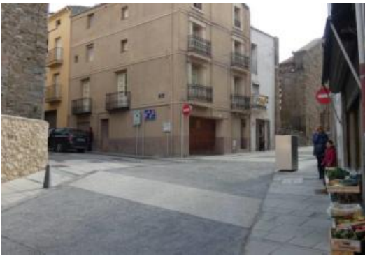
Imatge de les obres que es van realitzar durant el darrer any.
