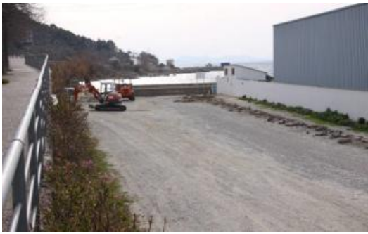
Roses comença l'obra per a l'aparcament de la platja dels Palangrers
