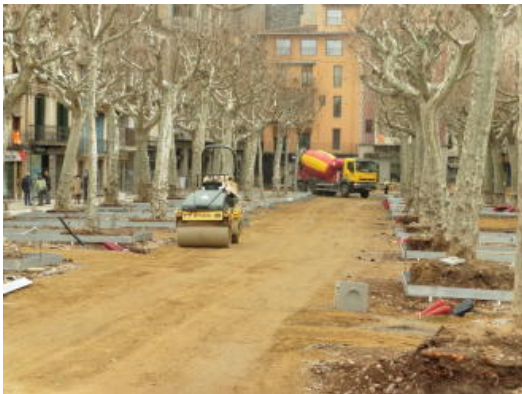
Un camió cuba ahir va començar a posar formigó a l'espai central del Firal d'Olot
