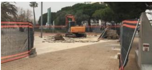
Els treballs que s'estan portant a terme.
