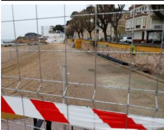
Imatge d'ahir de les tanques de l'obra a la platja.
