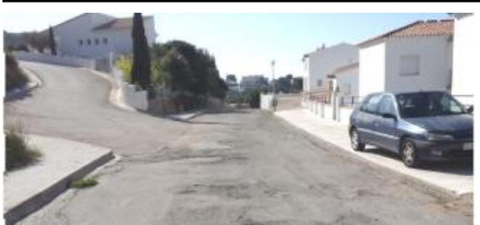
Roses comença avui l'asfaltatge de 36 carrers malmesos per arrels d'arbre
