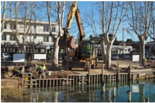
Les màquines excavadores, treballant, aquest dimarts, a la vora de l'Oficina de Turisme.
