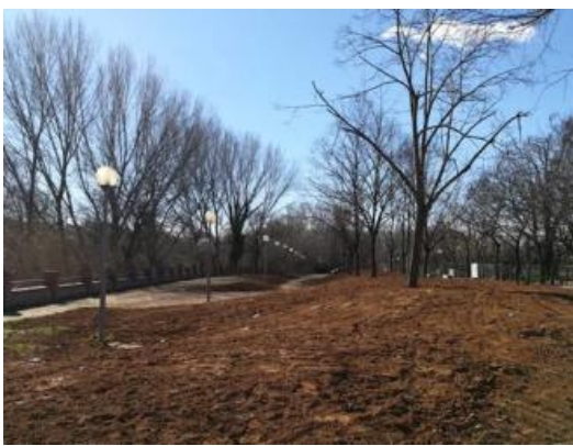
Una imatge de com està quedant el nou passeig del Riu.
