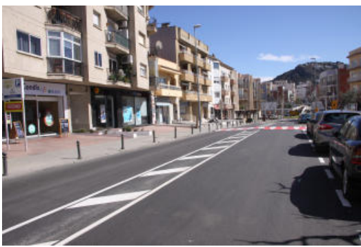
La Gran Via Pau Casals, amb el nou paviment.
