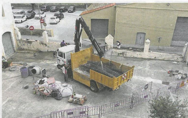
EN OBRES. Es canviarà el paviment i la tanca perimetral
