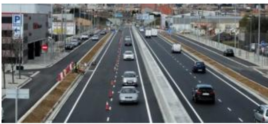
Els carrils desdoblats ja estan en funcionament.
