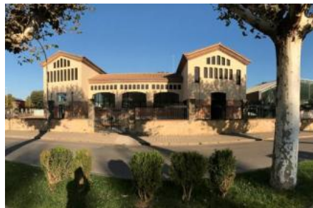
L'antic escorxador, amb la imatge rehabilitada després de la intervenció perquè aculli la biblioteca local. ddg
