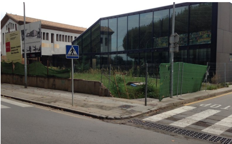
L'entorn de la biblioteca inacabada, amb la tanca a terra. JOAN PUNTÍ.
