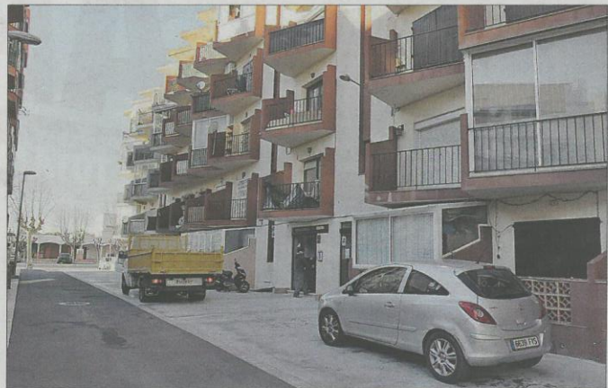
L'edifici d'Empuriabrava amb les portes d'accés noves després que s'hagi desprecintat. CONXI MOLONS
