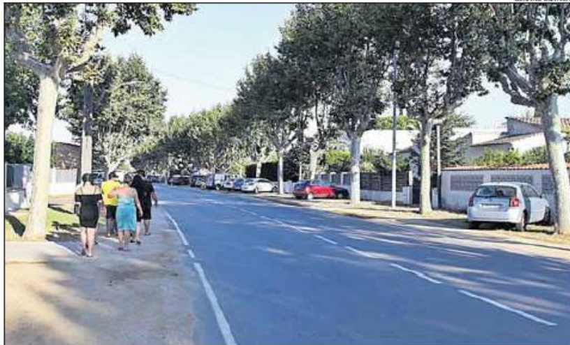
Fins ara, en algun tram els vianants havien de passar per camins de terra en comptes de voreres.
