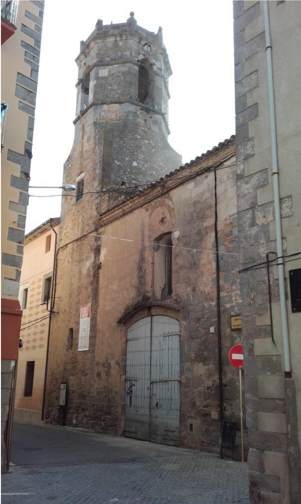
El projecte de restauració-conservació de l'antic convent compta amb el suport econòmic de la Diputació de Girona.
