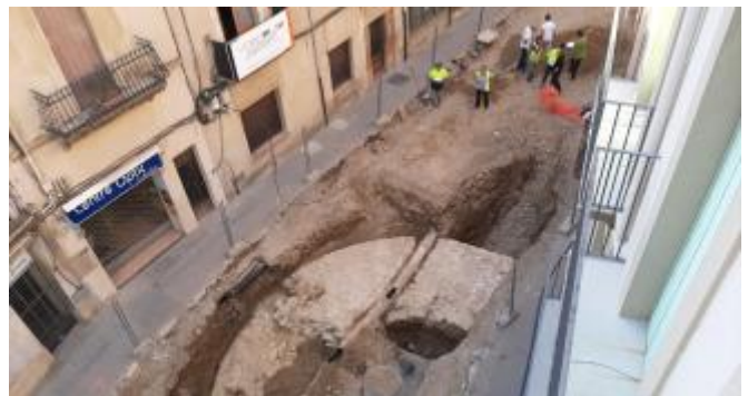
Les obres al carrer Ample de la Bisbal posen al descobert una torre medieval
